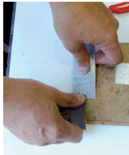
Krawędzie łączone należy dokładnie oczyścić z zanieczyszczeń i korozji.
